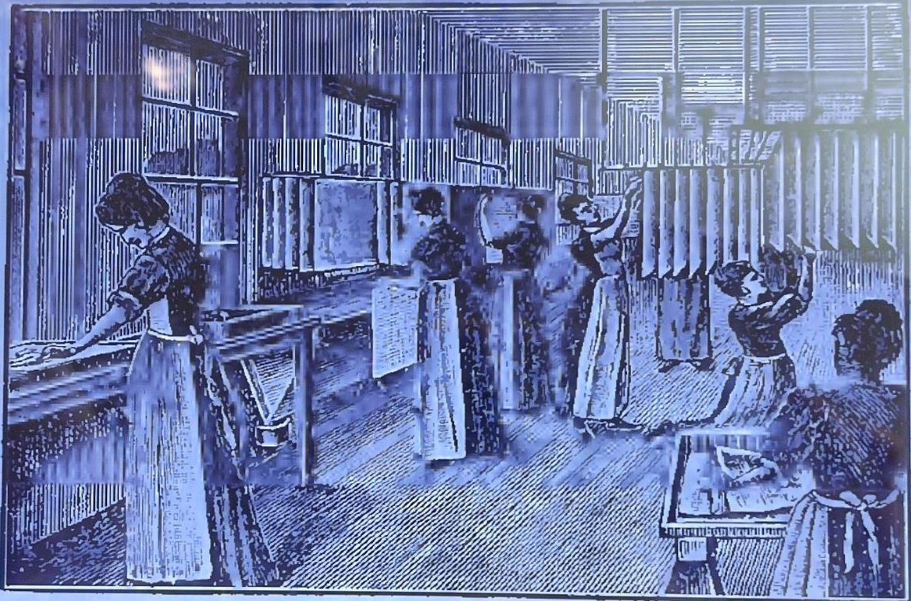
Fig. 46. Schwimmenlassen des Papiere auf dem flüssigen Albumin.
